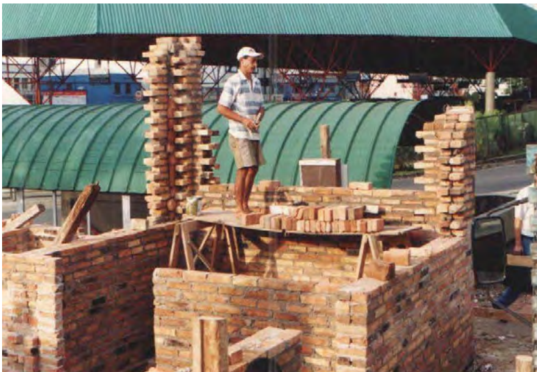
Figura 5 – Reconstrução da Casa do Agente Ferroviário em 2002
