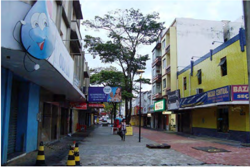
Figura 9 – Pavimentação em paver substituindo o petit pavet , em 2012
