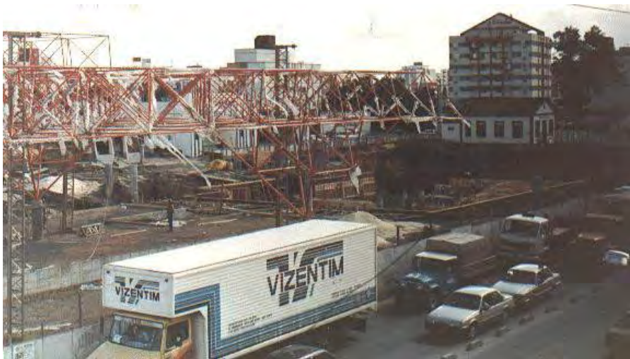
Figura 2 – Construção do Terminal Central, ao fundo no lado direito, a Casa do Agente Ferroviário antes de ser demolida, em 1995.
