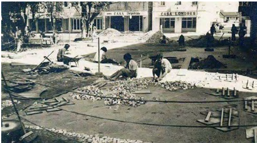
Figura 6 – Colocação do petit pavet em frente à Catedral São José, em 1977-78
